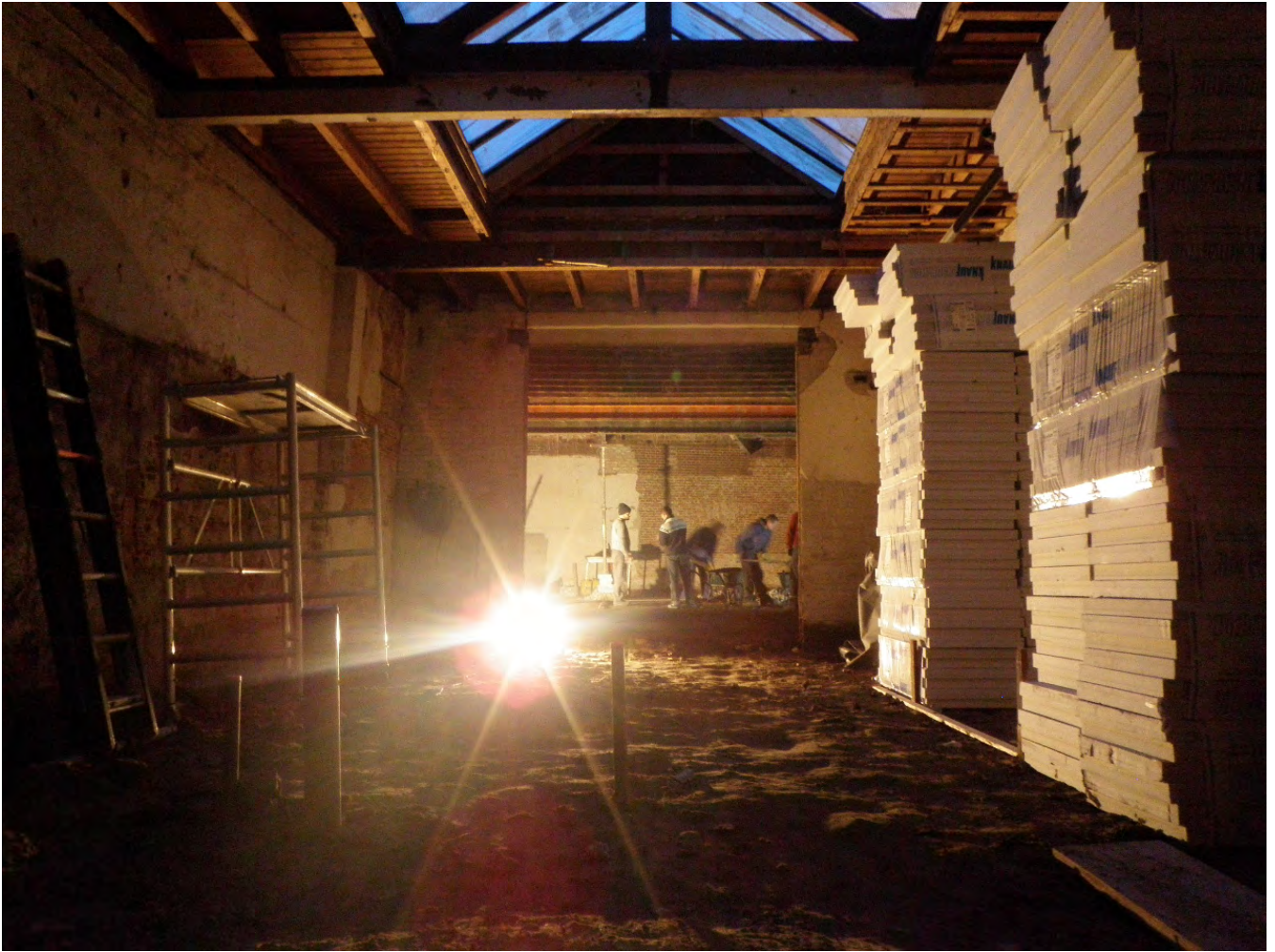
Fig. 2. Impressie van de onderzoekslocatie bij aanvang van de werkzaamheden.
